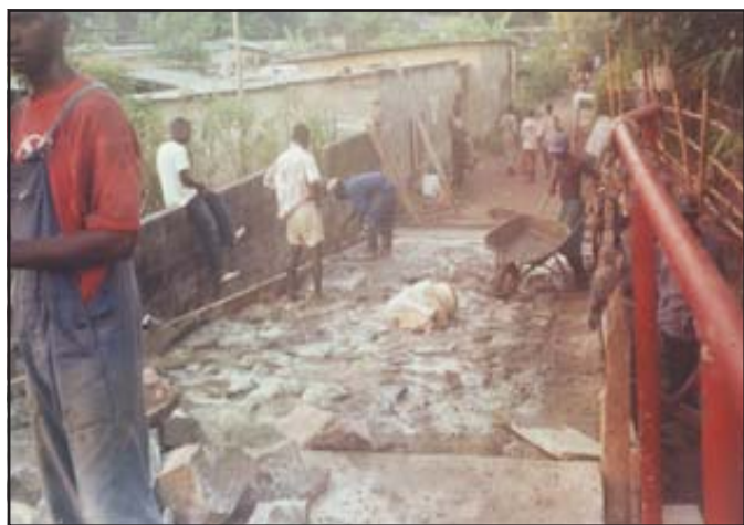
L'A.c.i.r une Ong locale de développement construisant une passerelle entre Moukondo et la Tsiémé. (Ph d'arch.)
